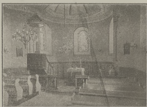
Wnętrze kościoła ewangelicko-reform. w Sielcu.
