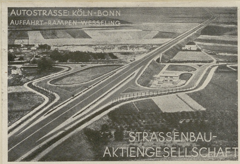
Rys. 9. Autostrada Kolonia—Bonn (zdjęcie lotnicze) przecina normalną szosę. Typowe skrzyżowanie autostrady z innym torem komunikacyjnym i połączenie obu dróg zapomocą ramp dojazdowych.
