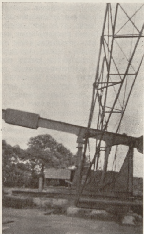
Rys. 19. Pompa o długim skoku „Wirtha“ na kopalni.
