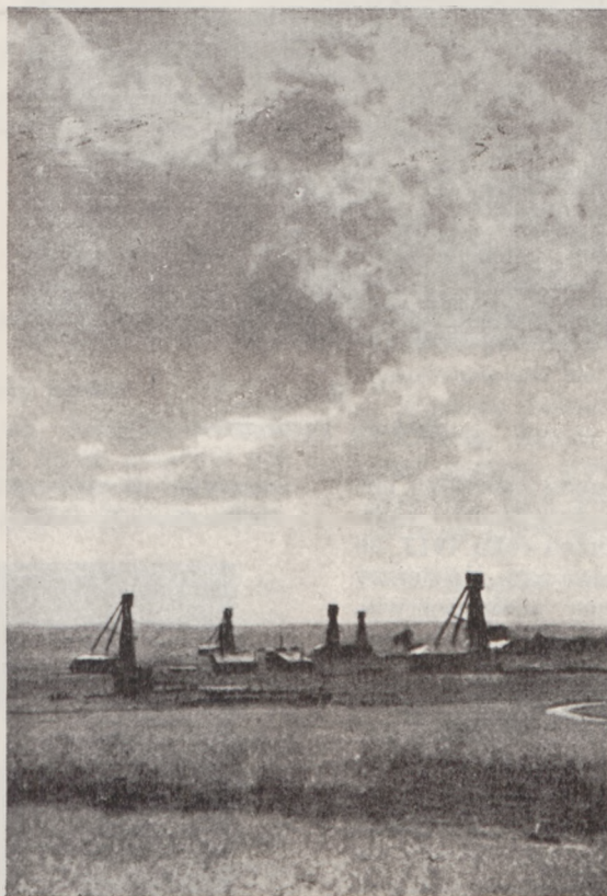
Rys. 1. Widok ogólny szybów w Roztokach.
