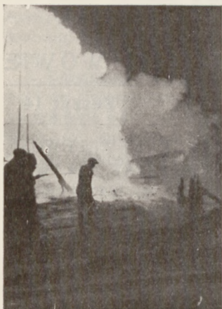
Rys. 2. Pożar szybu gazowego „Polmin 7“ w Roztokach.
