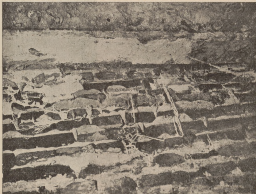
Rys. 1. Przewody grzyba domowego idące z zagrzybionej deski w stosugi muru fundamentowego.
