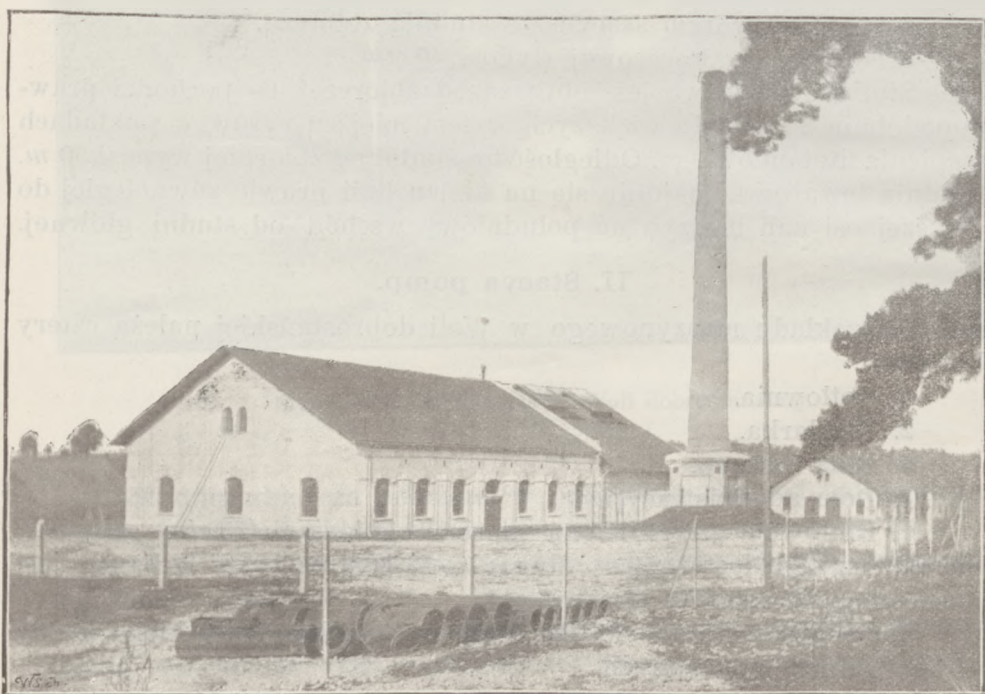
Fig. II. Hala maszyn stacji pomp w Woli dobrostańskiej.
