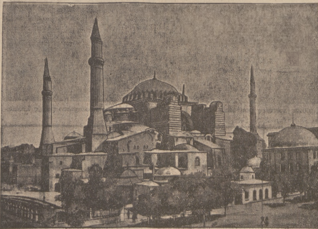
Sławnemu meczetowi „Aja Sophia“ w Konstantynopolu grozi ruiniecie. Pod jednym z filarów, na którym spoczywał główny ciężar sklepienia świątyni, odkryto ognisł sypane źródło, które podmyło fundamenty. Przedsięwzięto prace zapobiegawcze, konieczne dla ratowania tego wspaniałego arcydzieła sztuki i budownictwa średniowiecznego
