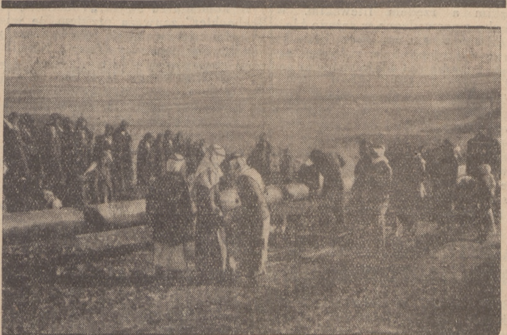
ZAKŁADANIE RUROCIĄGU NAFTOWEGO NA PUSTYNI SYRYJSKIEJ.
