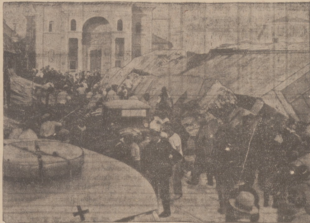
Przy prowadzonej od kilku miesięcy rozbiórce starego dworca kolejowego w Medjolanie zdarzyła się straszna katastrofa. Oto zawalił się wiadukt ponad jedną z najsilniejszych ulic, grzebiąc licznych przechodniów, którzy znaleźli pod gruzami okropną śmierć.
