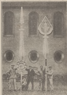
Poprzednie zdjęcie przedstawia wukawarki zegara kościola św. Piotra w Zurychu (Szwajcaria). Większa wskazówka jest długa 5 m. 73 cm., mniejsza 5 m. 7 cm. O rozumiarach ich najlepiej świadczą pasterie mężczyźni, podtrzymujących je.
