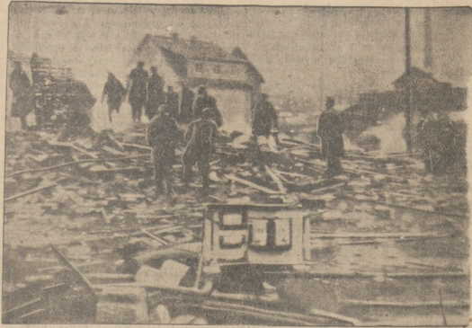
STRASZNE SKUTKI EKSPLOZJI. W Pleffenbergu (Niemcy Zachodnie) wskutek wybuchu gazu wycołwał w powietrze dom mieszkalny. W katastrofie śmierć poniosło pięć osób. Na zdjęciu ruiny zniszczonego domu
