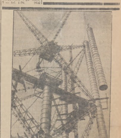
BUDOWA 175 METROWEJ WĘZY. W Odense w Danji wyrażają do budowy 175-metrowej węzy z rur.
