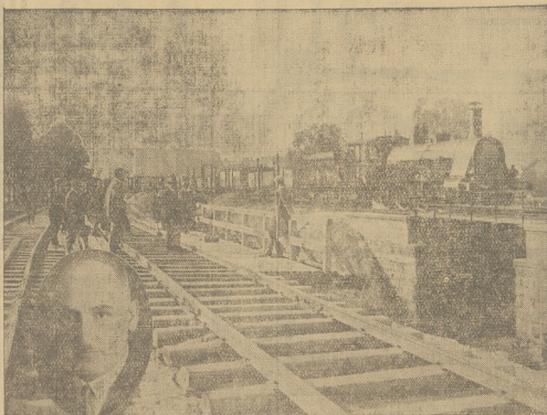
BUDOWA TUNELU KOLEJOWEGO W ZAWIERCIU.
