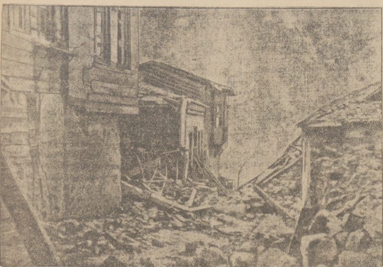
Kilka dni temu nastąpiło na brzegu tureckim Marmara silne trzęsienie ziemi...
