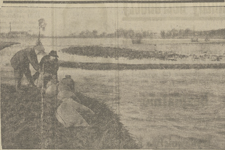
WYLEW WISŁY POD ZAWICHOSTEM.
