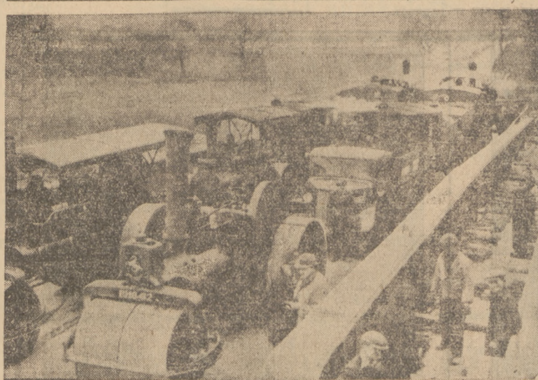
PRÓBA WYTRZYMAŁOŚCI NOWEGO MOSTU
