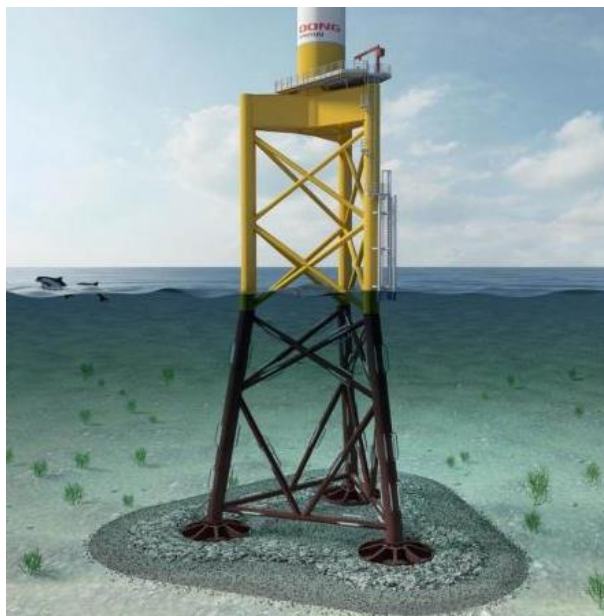
Rysunek 5. Fundament typu Jacket [16]
