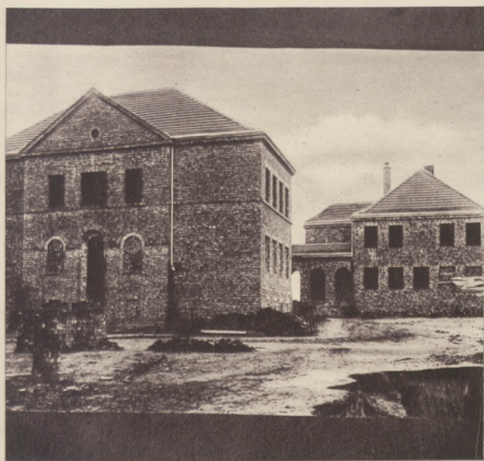
Zamknięcie robót na sezon zimowy zostało wykończony, pod dachem budynek szkoły i (na prawo) sale gimnastyczne. Rezultat niespełna 5 miesięcy wytrwałej i wytężonej pracy.
