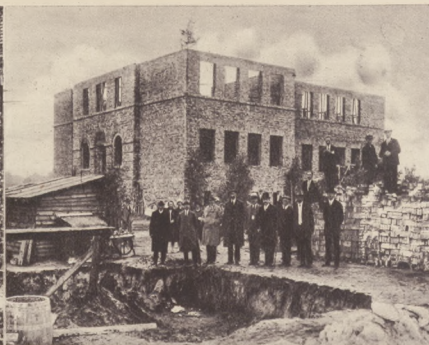
Budowa 7-klasowej szkoły powszechnej w Porębie pod Zawierciem. Rozpoczęta 10 czerwca 1929 roku, fotografia nasza przedstawia stan w dniu 4-go września 1929 roku.
