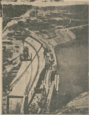
Słynne pole bitwy pod Maratonem zniknęło: stworzono na niem przez przegrodzenie dwóch rzeczek sztuczne jezioro, które będzie spontrynowało w wodę pobliską stolicę Grecji, Ateny. Ryciny przedstawiają tamę, spiętrzącą wody sztucznego jeziora.
