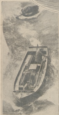
Nowy kabel podmorski na Bałtyku. z Abo w Finlandji do Norrtelji w Szwecji. Kabel długości 130 mil morskich, będzie służył do komunikacji telegraficznych i telefonicznych. Zakładania kabla dokonali sprężalni statek "Nordmey", zaopatrzone w olbrzymie role i belny do odwinania i opuszczania kabla do morza. Płynący znaczni drogę, w których kabel pograżono.
