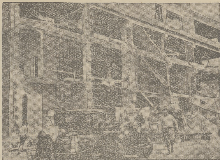
Zrujnowany dom pod Waszyngtonem, służący weteranom wojennym za schronisko w czasie obozowania w stolicy Stanów Zjednoczonych. Jak wiadomo, wielotysięczne rzesze weteranów oblegają Waszyngton, upominając się o renty.
