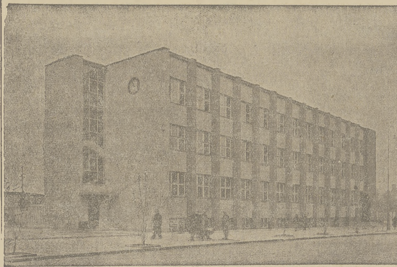
NOWY GMACH IZBY PRZEMYSŁOWO-HANDLOWEJ W SOSNOWCU.
