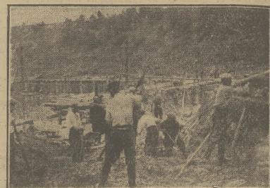
Na budowie zapory wodnej w Turniszczach
