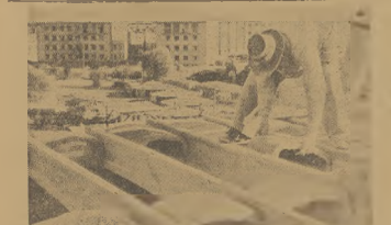
Zastawianie gruru w nowych budowlach. Przy budowie dwunastokondygnacyjnej W. S. 14 na Zabłotcu zastosowano na raz pierwszy przy budowie stropów i zw. „garanki”, fabrykowane z cementu ceglanołupianego. „Garanki” układają się pomiędzy helki szelbetonowe i walew. się cementem, uzyskując bardzo dużą trwałość, izolację i oszczędność.
