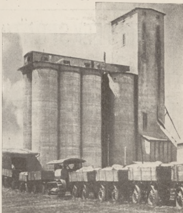
Elewator kolektywu „Gigant“ obliczony na ładunek 3.330 ton
