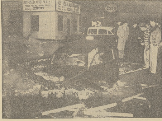
Frank Duggan z Bostonu i Daniel Kelly z Somerville jadąc samochodem rozbili barykadę w Dorchester, Mass. i wpadli do dolu rozkopanego przed fabryką Edisona. Wyplodeł był o tyle groźny, że spowodował eksplozję.
