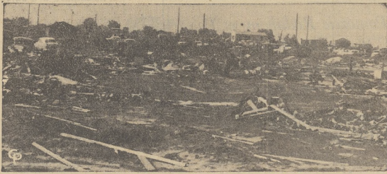
Powyższa scena przedstawia resztki 60 domów zruwanych przez tornado, które przeszło przez Olton, Texas.
