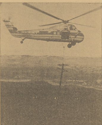
W górach Santa Inez, California jest używany do zakładania przewodów elektrycznych helikopter pod nazwą "Sikorski". Prace, które normalnie są wykonywane dwa miesiące, przy pomocy helikoptera są robione w dwudniach.
