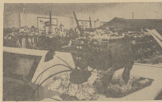
W miejscowości New Castle, Ind., huragan zerwał dach w dużym sklepie spożywczym, wyrządzając szkody na 100 tysięcy dolarów.
