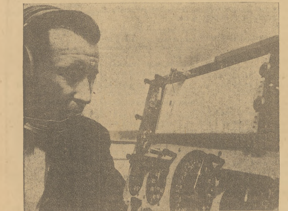
Kpt. Irwin J. Kersey, latając helikopterem nad dzielnicą Nowego Yorku Manhattan demonstruje nowy aparat, który automatycznie wskazuje na kartogramie dokładną pozycję samolotu. Instrument ten został nazwany Bendix-Decca Navigator.
