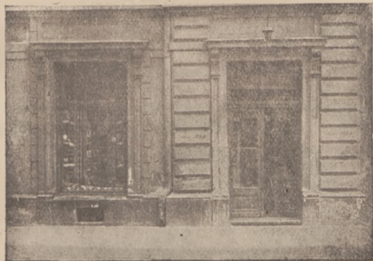
Ilustr. 1. Sklep przy ul. Siennej 1.
