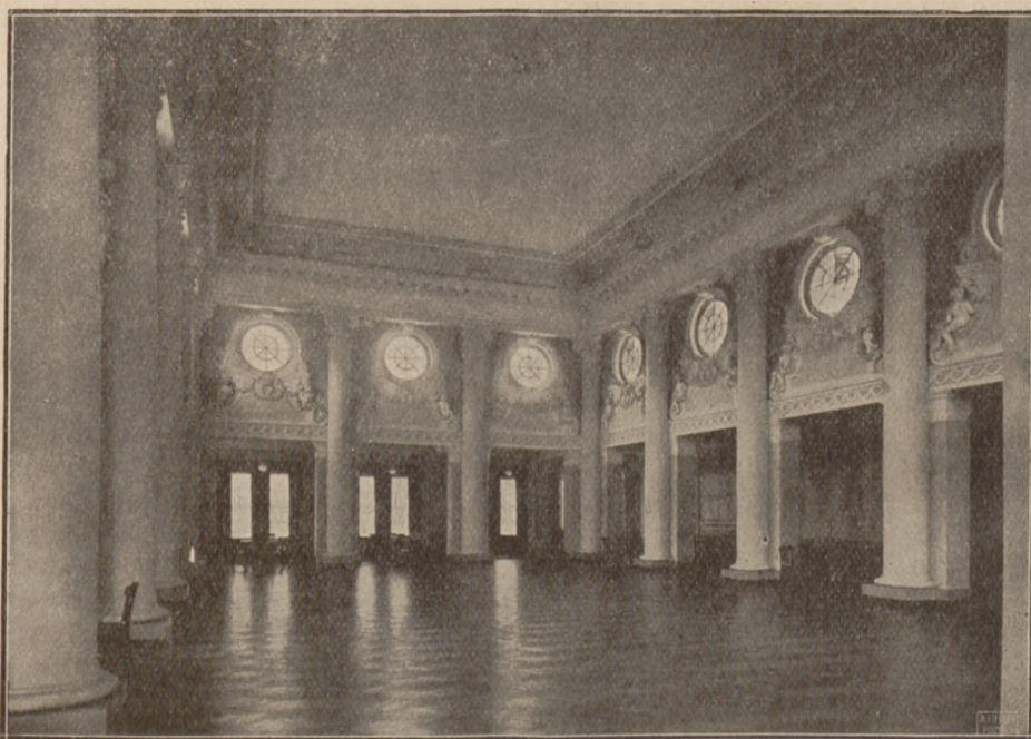
Sala recepcyjna w Domu Administracyjnym Międzynarodowego Targu w Poznaniu.
