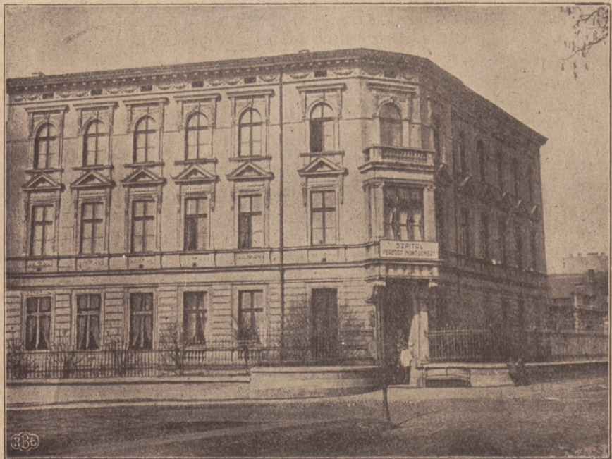
Das Krankenhaus „Bethlehem“.
