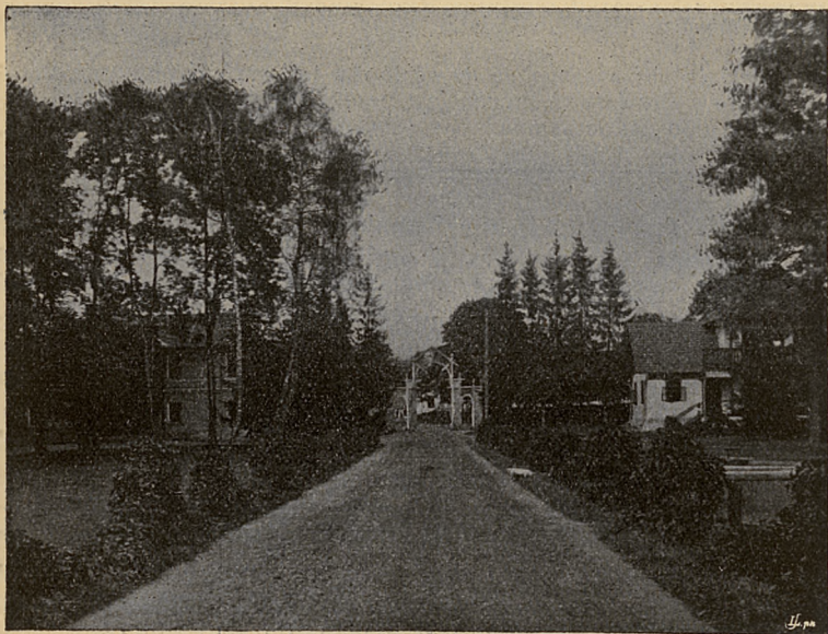
Lubień. Wjazd do parku zdrojowego.
