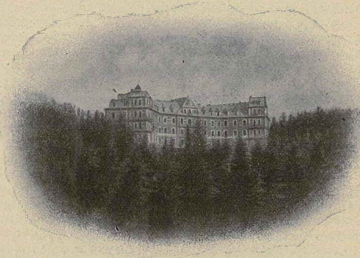
Sanatorium Dra Dłuskiego w Zakopanem. Widok ogólny.
