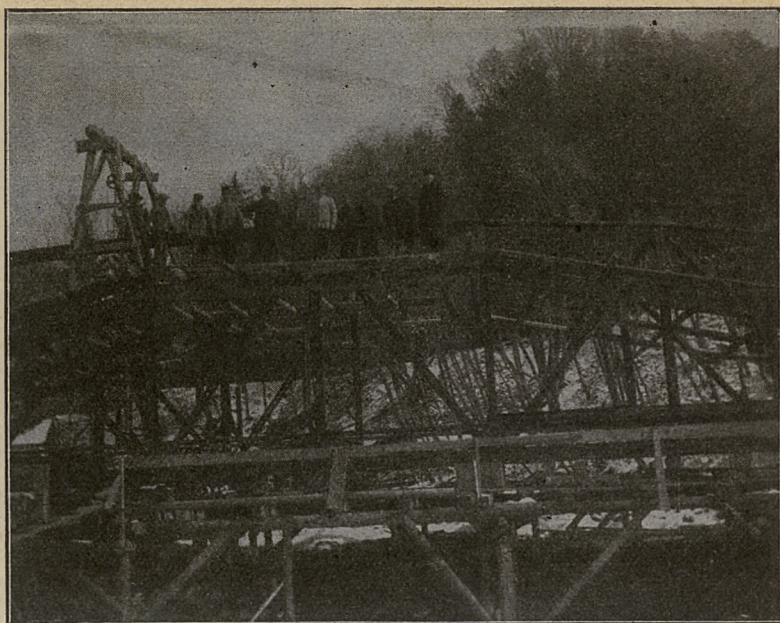
Most żelazny nad rzeczką Kryniczanką na drodze dojazdowej ze zdrojowiska do dworca kolejowego w Krynicy, nad parowem, na granicy parku zakładowego.
