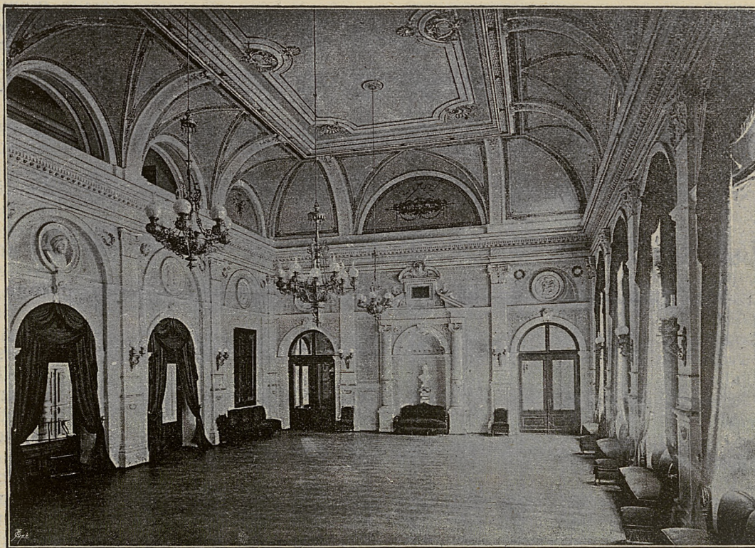
Sala posiedzeń II. Zjazdu przemysłowo-balneologicznego w Domu zdrojowym w Krynicy.
