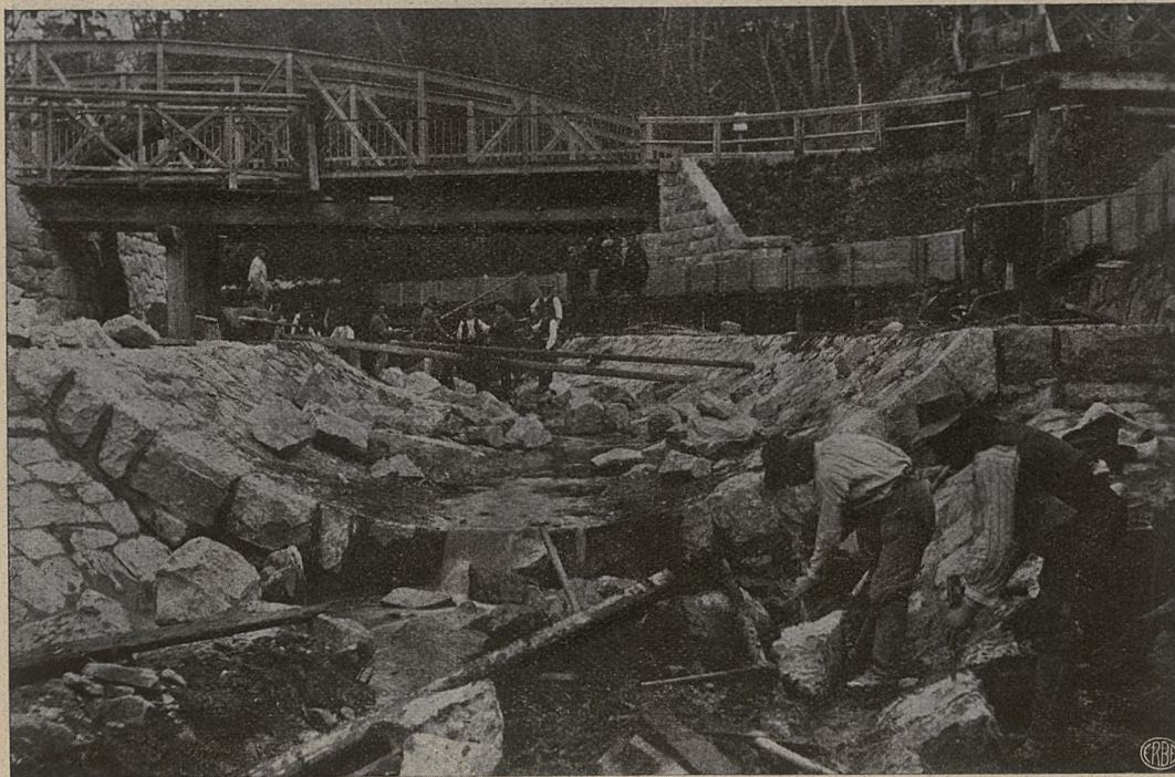
Krynica: Regulacja potoku Kryniczanka i budowa łożyska granitowego.
