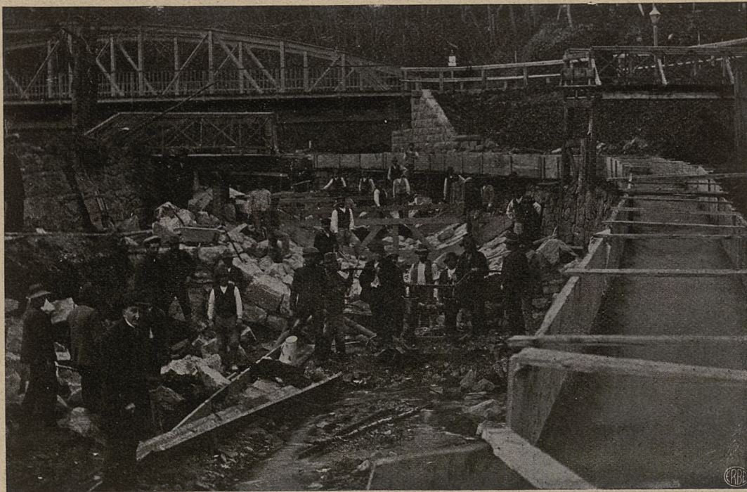
Krynica: Regulacja potoku Krynicyzanki i budowa łożyska granitowego.
