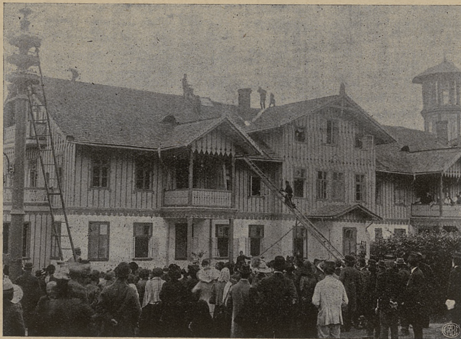
Truskawiec: Ćwiczenia zakładowej straży ogniowej na gmachu łazienek mineralnych.
