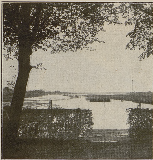
Widok z Brdyujściu na port zewnętrzny i Wisłę.
