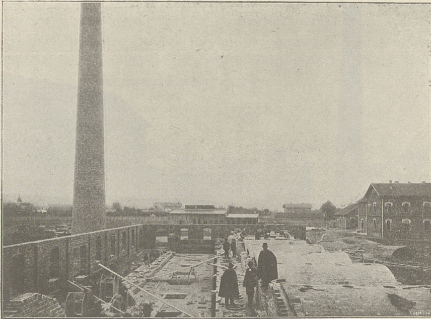
Rys. 2. Szamotownia w Skawinie: widok w czasie budowy pieca Mendheima. W głębi na prawo budynek administracyjny, wprost stajnie i magazyny, na lewo widać miasteczko i stację kolejową.
