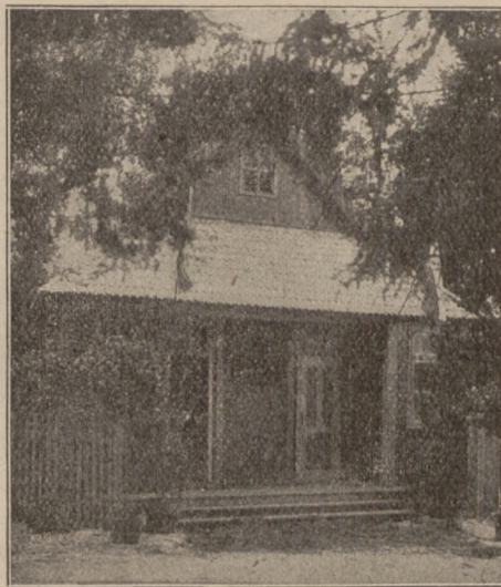
Domek przenośny zbudowany w ciągu 36 godzin według systemu inż. Fr. Kulikowskiego.
