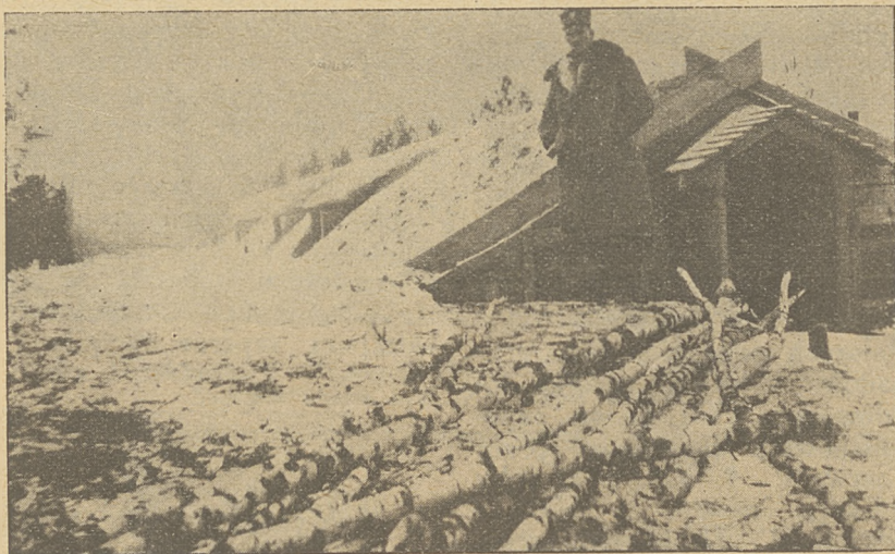
Ziemianka w Leśniczówce, zbudowana przez 7 p. saperów nad Berezyną.
