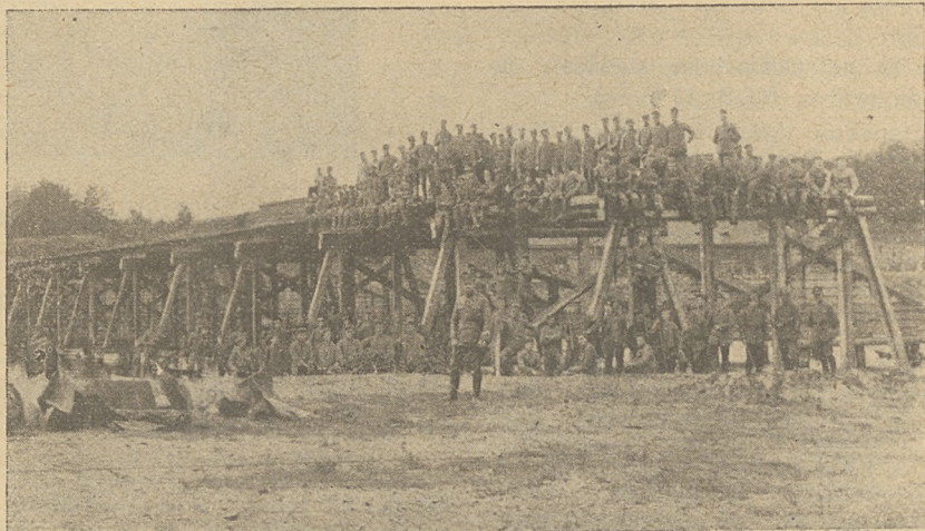
2 komp. 7 p. sap. przy budowie mostu im. gen. Konarzewskiego na Berezynie pod Bobrujskiem.
