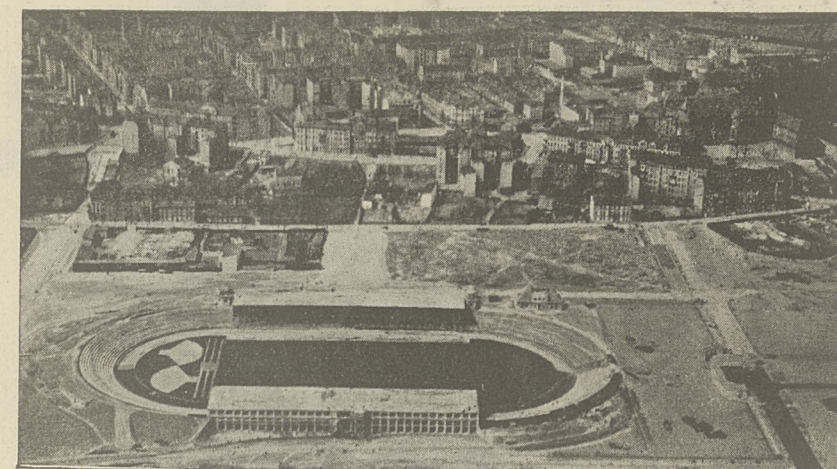
Stadjon Miejski z lotu ptaka podczas budowy.
