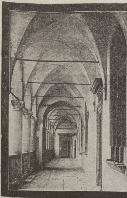
Fragment kolumnady na dziedzińcu zamkowym
