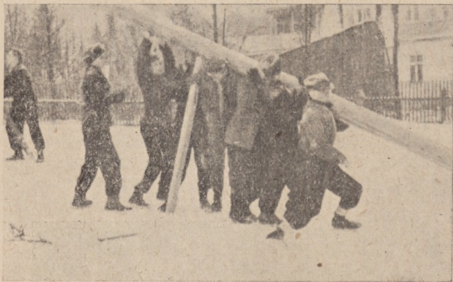
Stawianie masztu, na którym za chwilę powiewać będzie flaga
