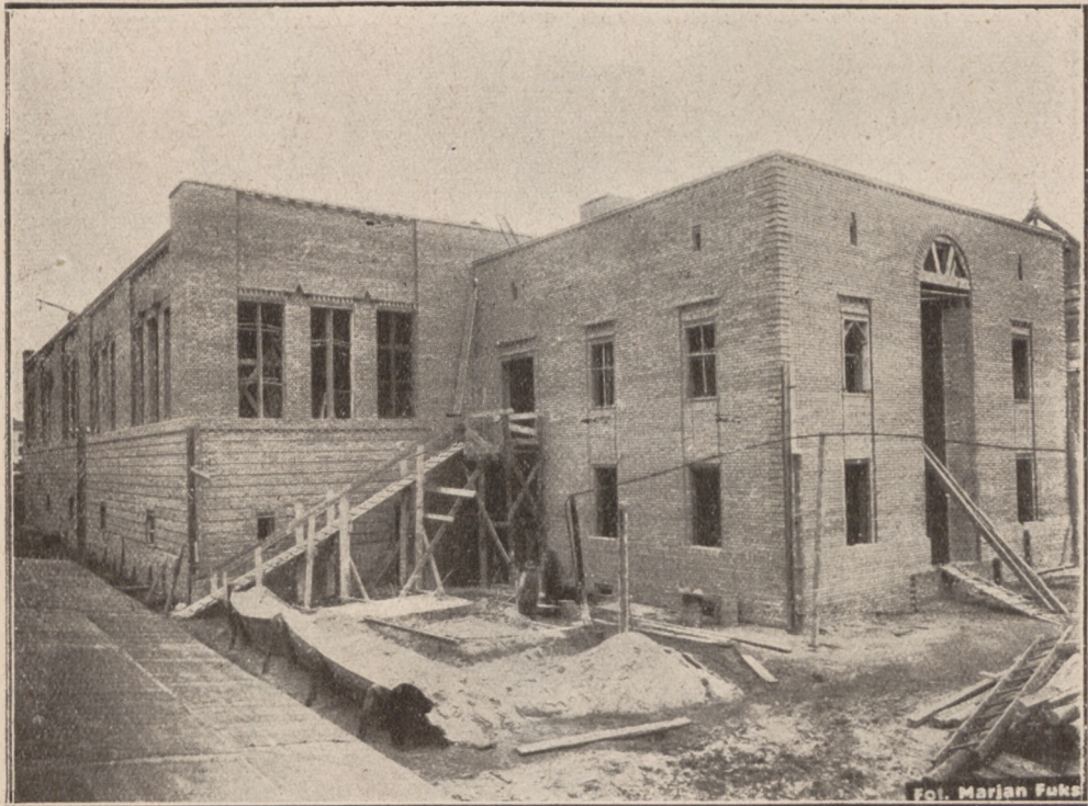
Gmach Instytutu Aerodynamicznego podczas budowy
