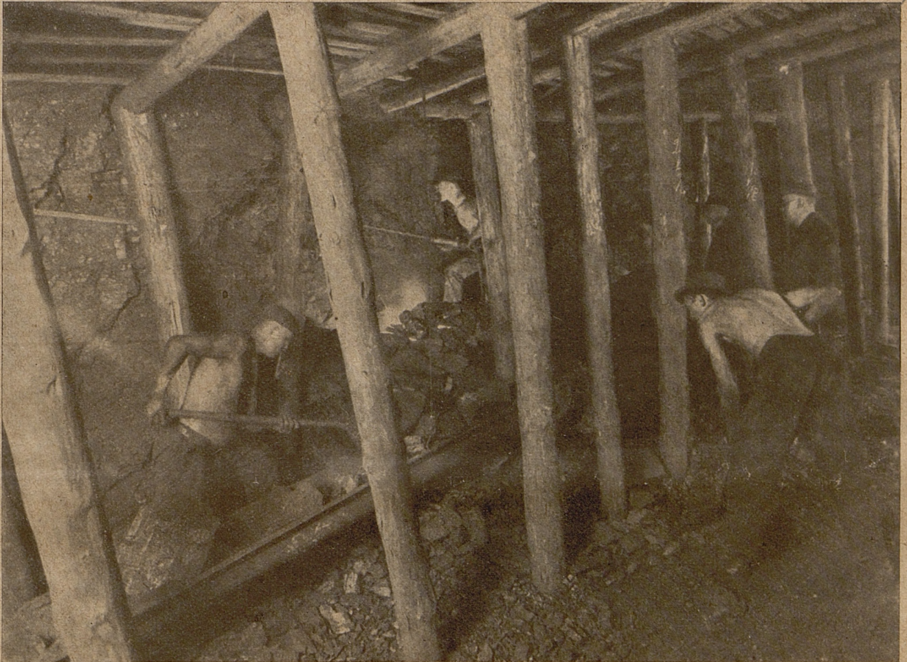
Kopalnia Hr. Laura w Chorzowie: Szyb kolejowy.
