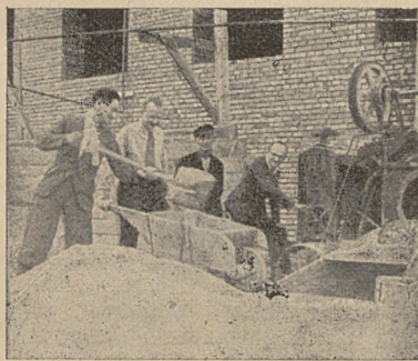
Komendant Chorągwi Warsz. hm. H. Weksler i jego zastępca hm. St. Zakrzewski oraz Komisarz Zbiórki hm. K. Jelski pracują przy budowie domu Z. H. P.
