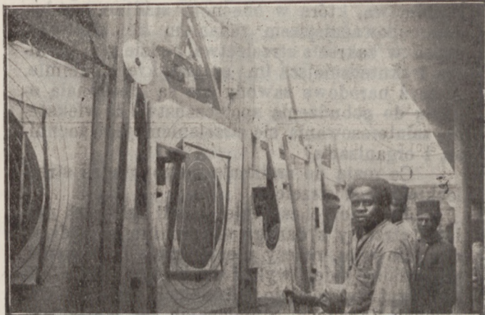
Tarczownia na strzelnicy w Tourcoing.
