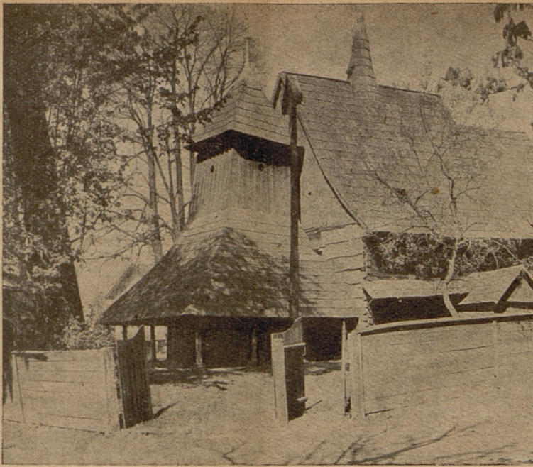
Zabytek architektury śląskiej XVI w. Kościół drewniany w Łagiewnikach Wielkich, powiatu lublińskiego.
