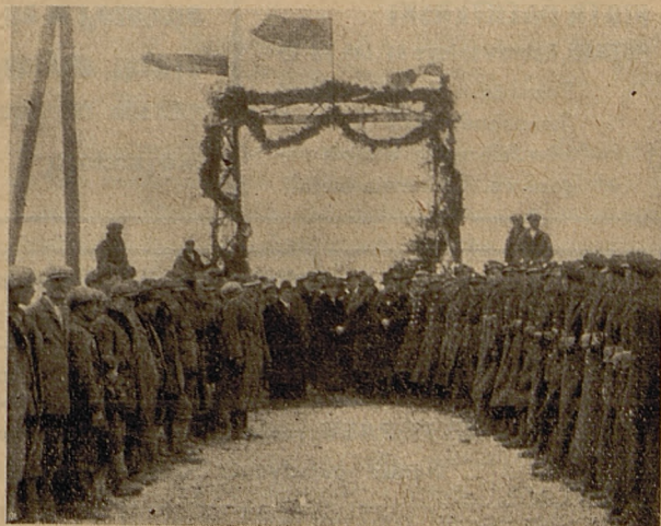
W Mielcu odbyło się poświęcenie odbudowanego przez miejscowy Oddział Z. S. mostu na Wisłocę, który powódź zniszczyła całkowicie.
